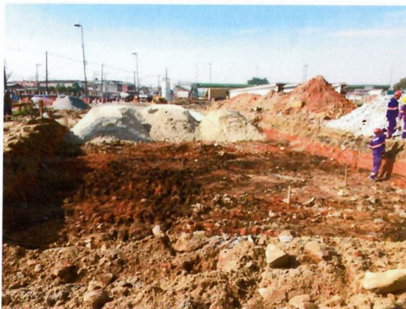
Figura 14: Início das escavações no Ramo 500
