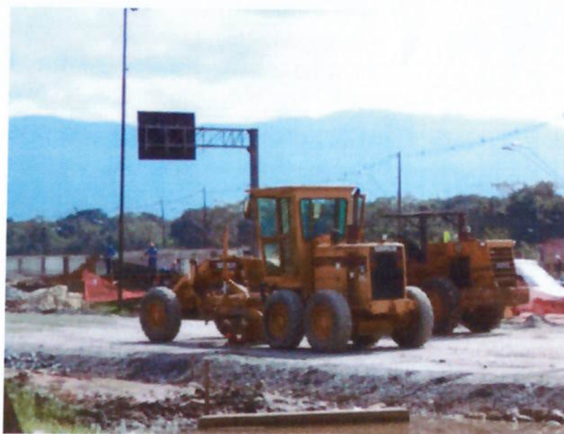
Figura 20: Lançamento do BGS com Motoniveladora
