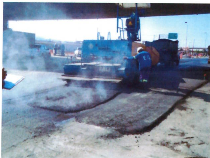
Figura 23: Aplicação da camada de CBUQ do Binder
