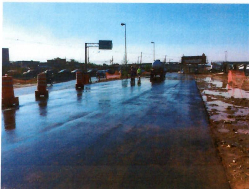
Figura 24: Capa do Ramo 500 realizada aguardando a pintura das faixas
