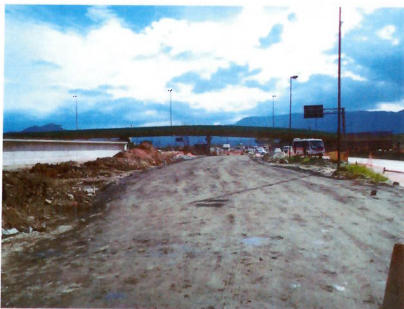
Figura 22: Camada de BGS imprimada
