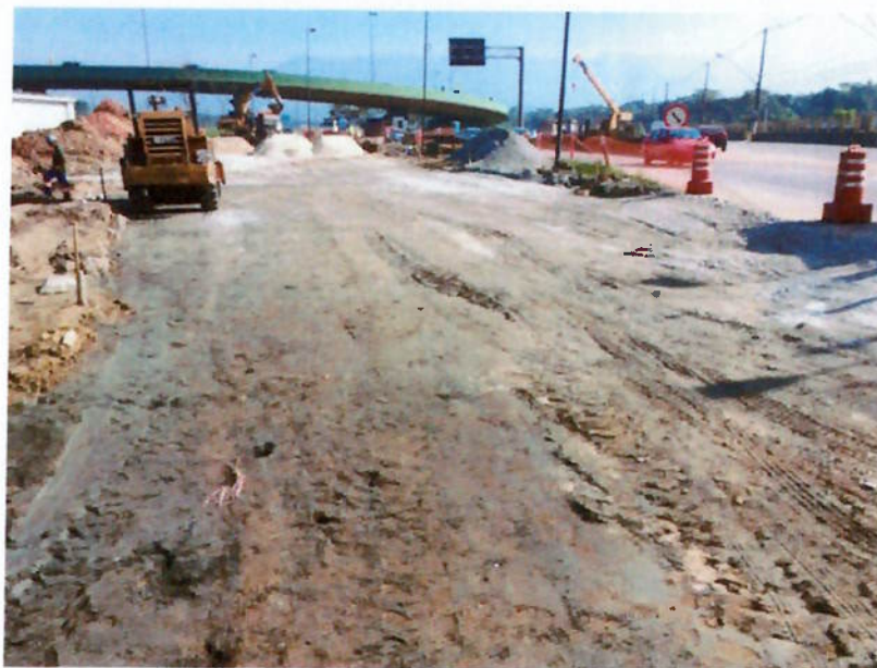
Figura 16: Rachão travado no Ramo 500
