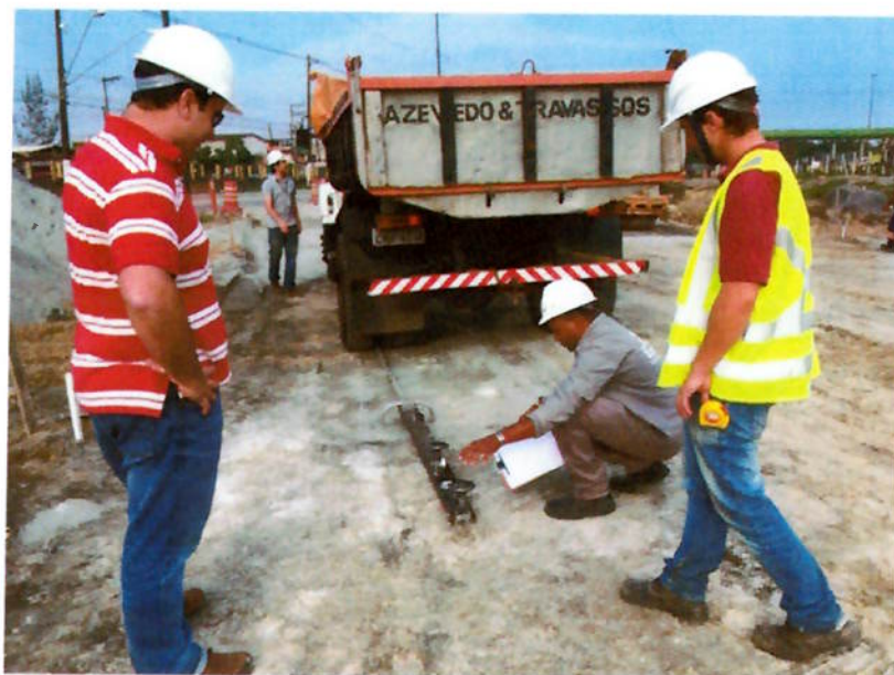
Figura 18: Realização do ensaio de deflectometria no Ramo 500
