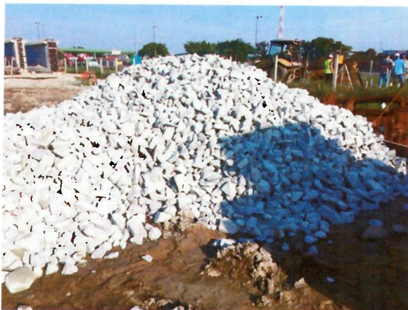
Figura 13: Rachão recebido na obra para aplicação no Ramo 500
